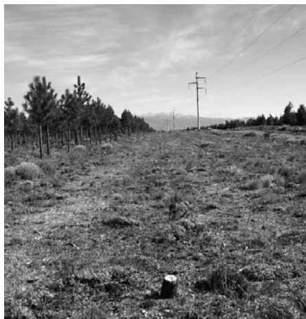
Transformación de camino en cortafuego y ampliación por existencia de línea de alta tensión.
