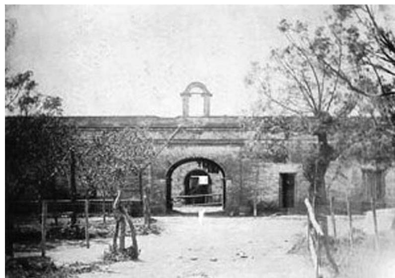
ENTRADA AL EDIFICIO DE LAS CRUJÍAS, FOTOGRAFÍA TOMADA EN 1901, MUSEO SAAVEDRA
